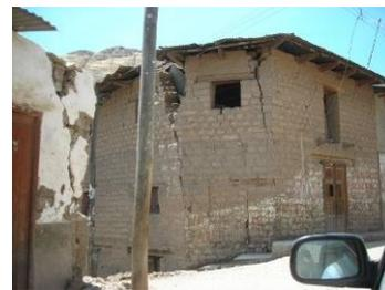
④地震で壁が面外方向へ変形生じたクラック 屋根が一部崩落している
