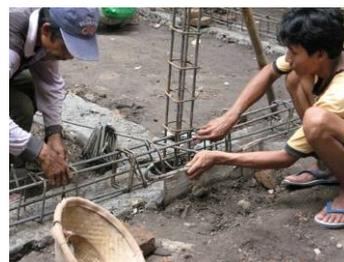
⑦建設労働者らが困難であると話していた構造部材交差部の鉄筋処理
