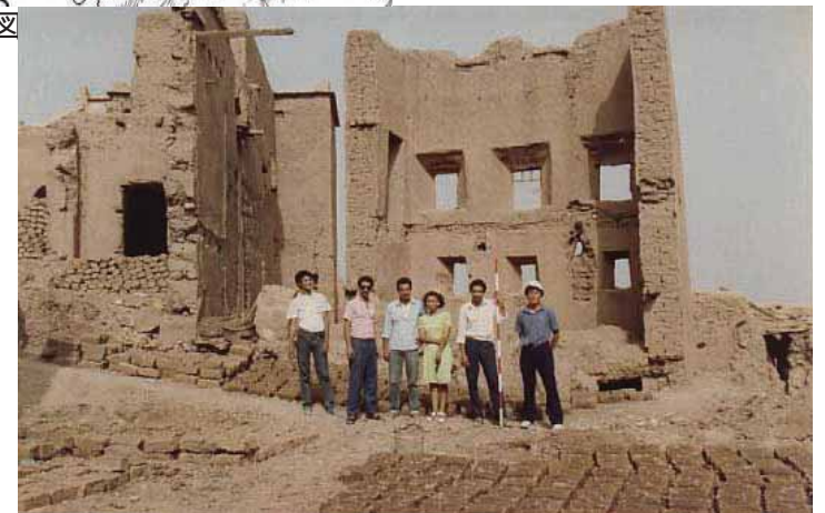
当センターが出来る前の測量をしている時(右端遠藤隊員) 写真の手前は日干し煉瓦を作り、干している状態。
