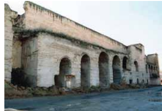
マンスール王宮崩れた北側ファサード 1997年
