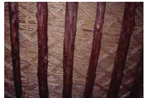
カスバの天井、太いものは梁、 梁の上に葦を化粧天井に敷いている
