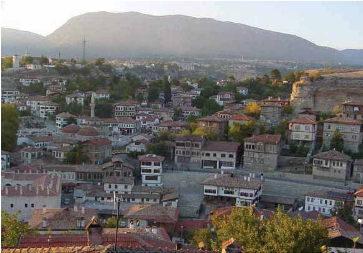
サフランボルの全景
