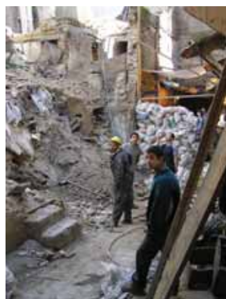
2004年の地震後の建物崩壊
