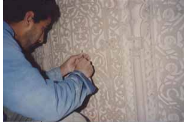
壁面漆喰にモロッコ・アラベスク細工を施す職人
