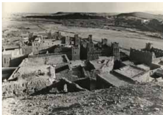
崩壊寸前の頃、 集落上部から見た風景 （左写真）
