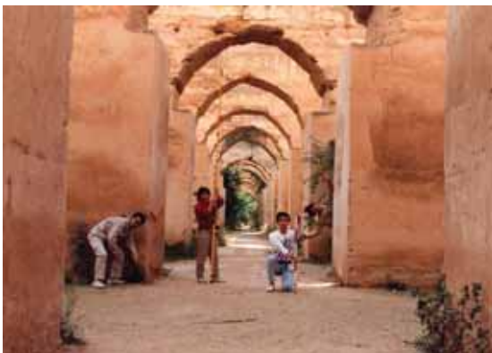
ヘリ 穀物倉庫跡
