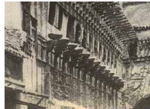
ブー・イナニアの正面にある通り沿いの水時計。 高度な技術を駆使し、水により時刻を街の人に伝えた装置。 1970年代に、イタリア人建築家やユネスコが修復に乗り出したものの詳細が分からず、復元できなかった。
