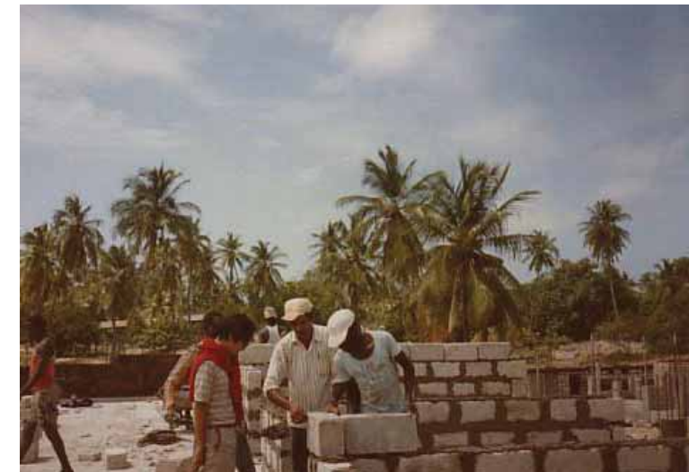
ラム県立病院（予定）建設現場にて渡辺隊員
