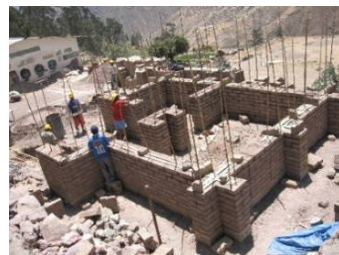
ペルー耐震アドベ住宅工事の様子
