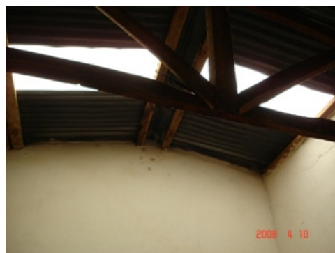
カウンセリング室室内の屋根部
