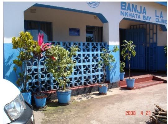
通り沿い正面玄関に設けられたブロック塀
