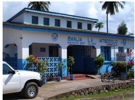
道路から建物中へ続くスロープ
