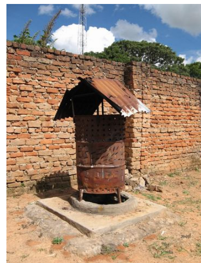
HTC センター横に設置されている焼却炉
