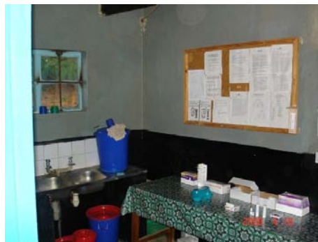
検査室(塗り直し前)
