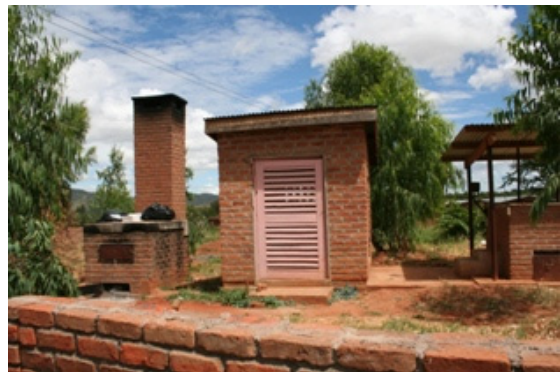
ブロック塀の中に設置された焼却炉
